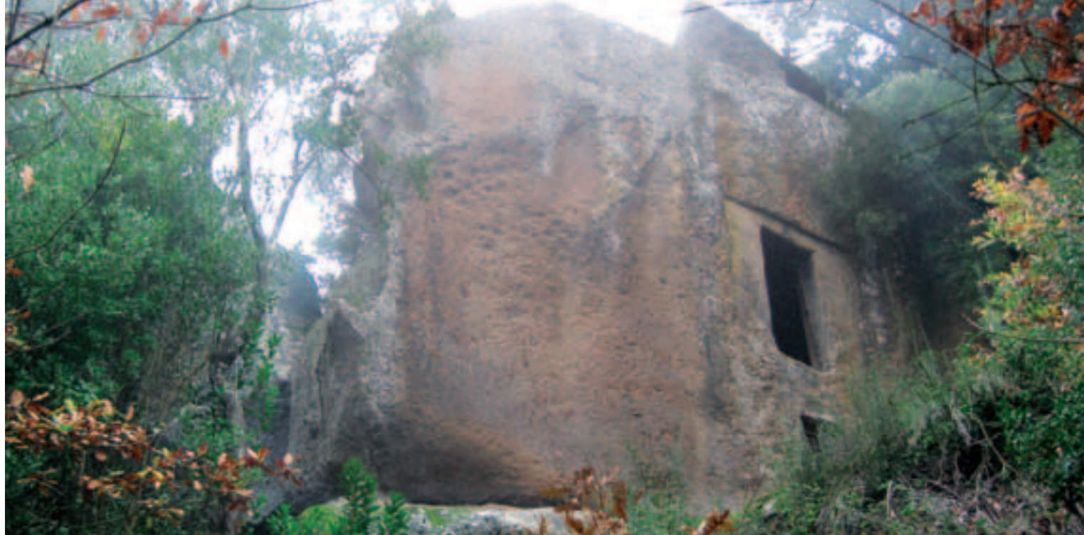
Romitorio in località Tacchiolo.
